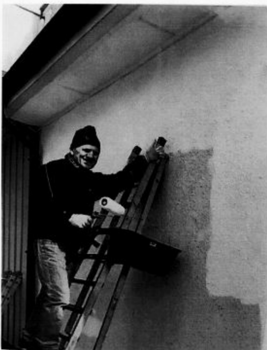
Her er maler Per Bekken i gang med murveggen mot parkeringsplassen.
